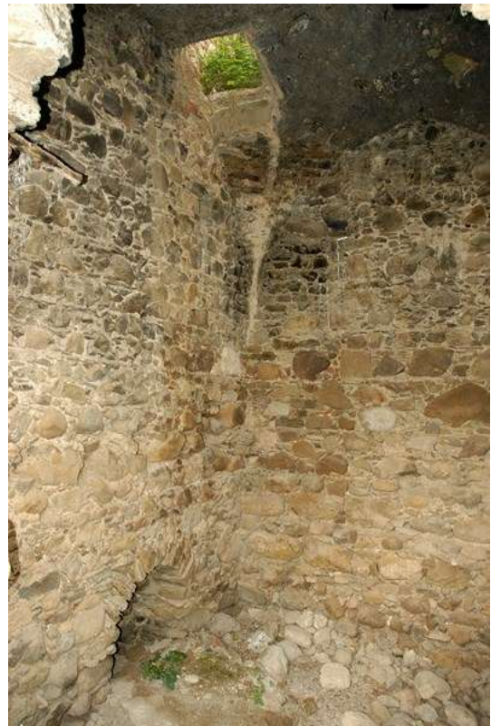
Base della torre
