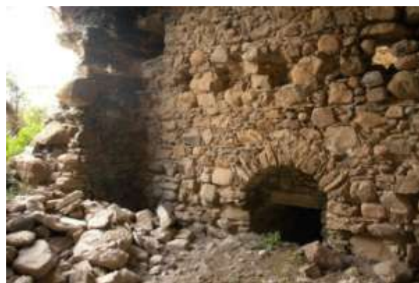
Base, particolare del cunicolo
