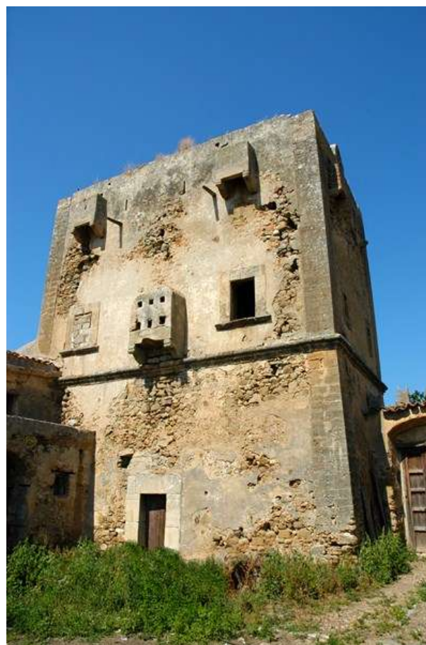
Prospetto ovest della torre
