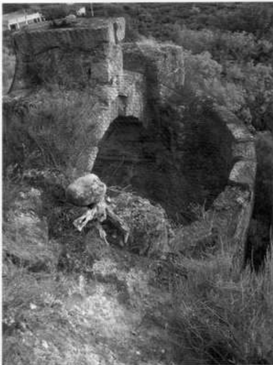
Figura 1. Foto dei resti di una senia sita nel territorio di Lascari (PA), in cui è visibile la rampa elicoidale su cui salivano gli animali che facevano ruotare gli ingranaggi della ruota, usata per sollevare l'acqua dal sottosuolo per la macinazione del grano.
